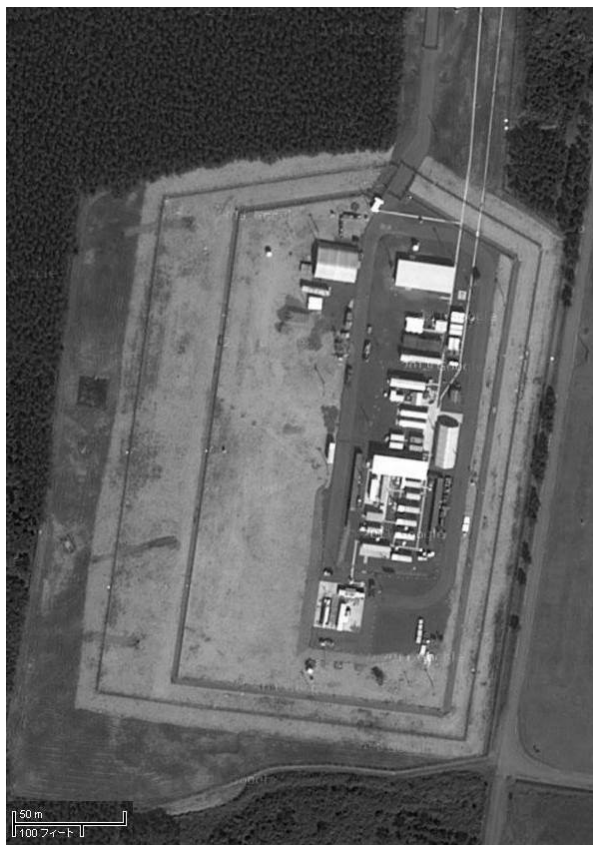
通信所の全景
