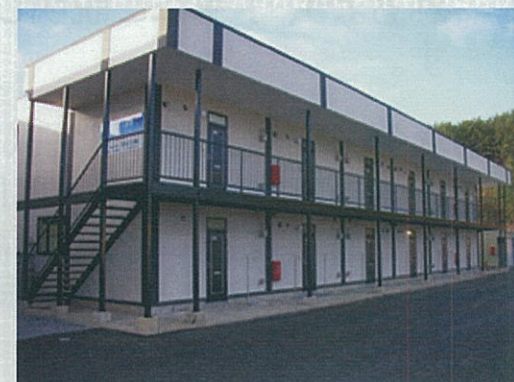
車力通信所に隣接する借上住宅
