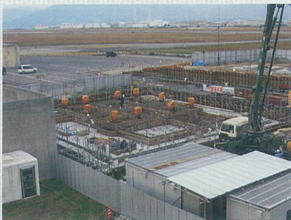
施設の建設工事の様子（イメージ）
