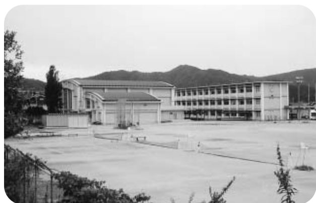
地震・災害にだいじょうぶか体育館
