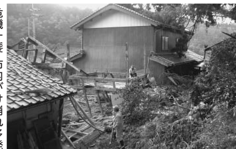
危機一髪 市内がけ崩れ多発
