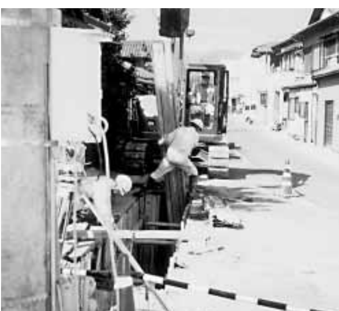
公共下水の工事（峰山地内）
