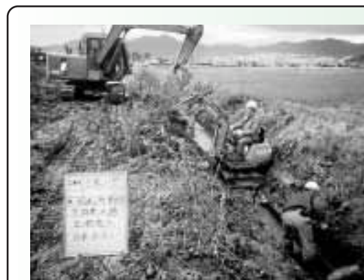
水路災害復旧農道工事
