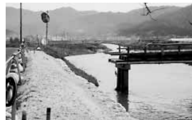
落ちたままの島大橋
