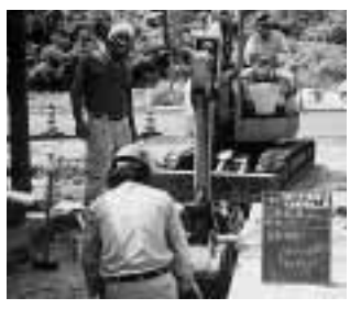
水道改良工事
