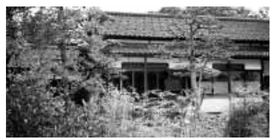
下岡ふれあいホーム改修中
