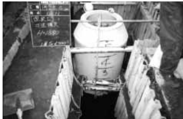
下水道のマンホール工事
