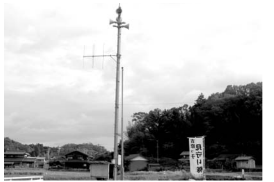
早期設置が望まれていた防災行政無線
