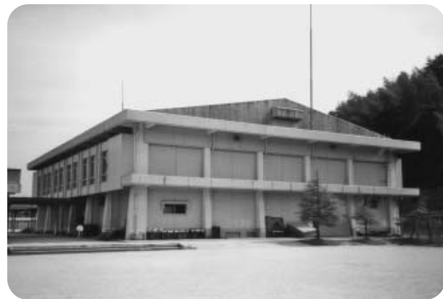
耐震化改修が望まれる学校施設
