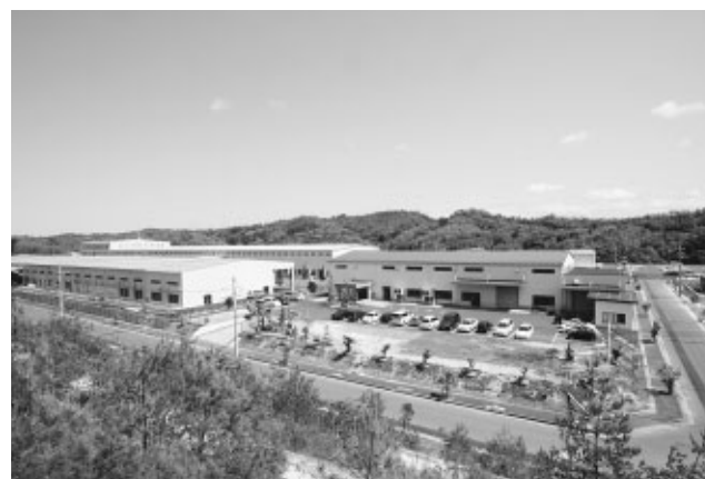
機械金属など多くの事業所が操業する赤坂工業団地
