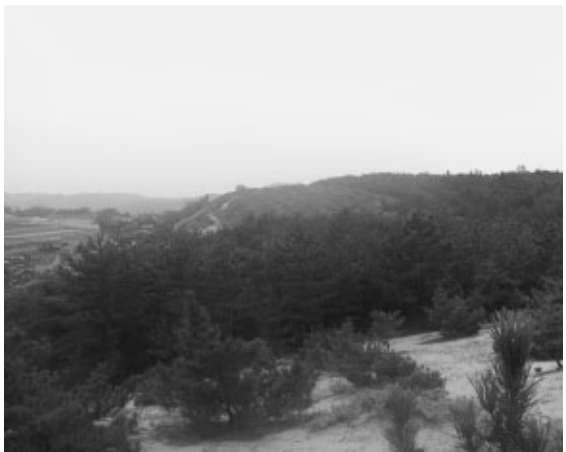
採砂工事現場
