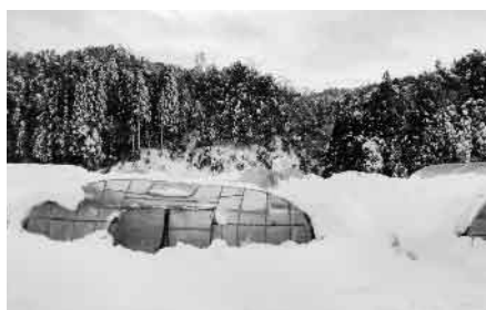
大雪で被害を受けたパイプハウス
