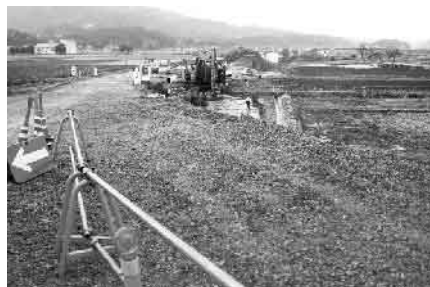
工事が進む丹後弥栄道路
