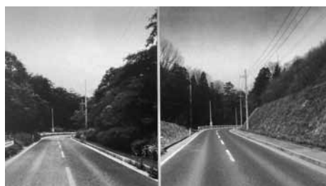
右、施工後。随分すっきりしました
