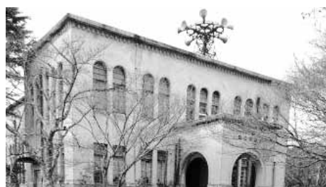
整備されていない丹後震災記念館
