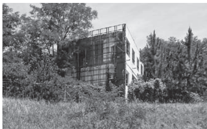
無償譲渡する旧校舎
