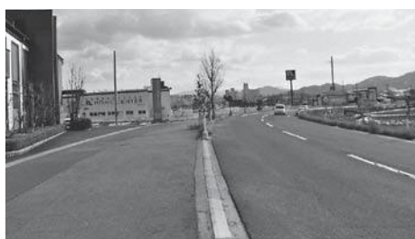
峰山インター線の接続地周辺から南方を望む
