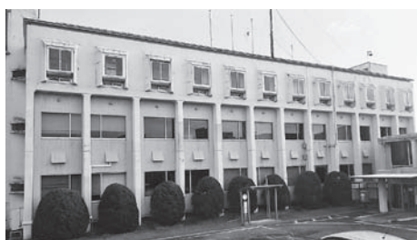
解体が予定される網野庁舎
