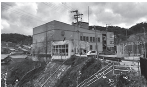
耐震強度不足が判明した丹後地域公民館
