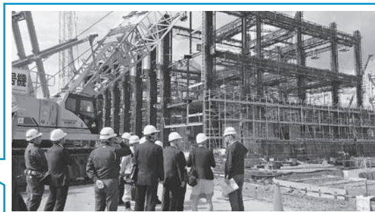
新ごみ処理施設建設現場での説明（水戸市）
