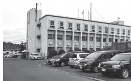
解体・撤去予定の網野庁舎
