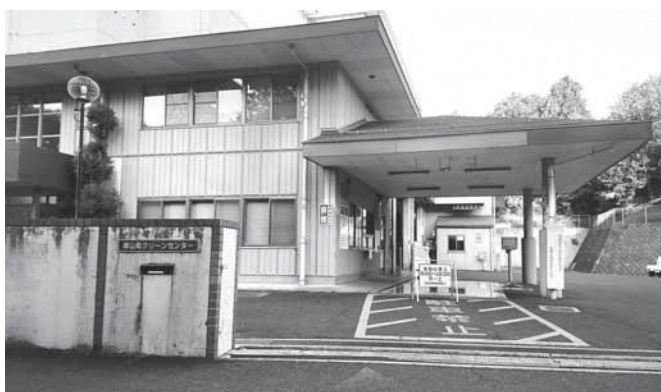
ごみの再資源化と焼却を担うクリーンセンター
