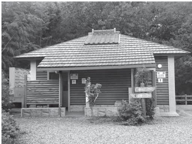
整備された「かぶと山園地」のトイレ
