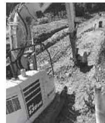
災害復旧工事継続中
