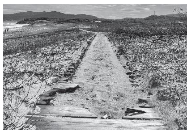
焼損した箱石海岸の遊歩道
