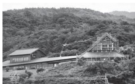
改修工事の遅れる宇川温泉
