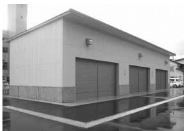
新しい防災倉庫
