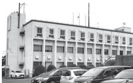
解体前の網野庁舎
