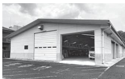
庁舎増築棟の建設地、防災倉庫
