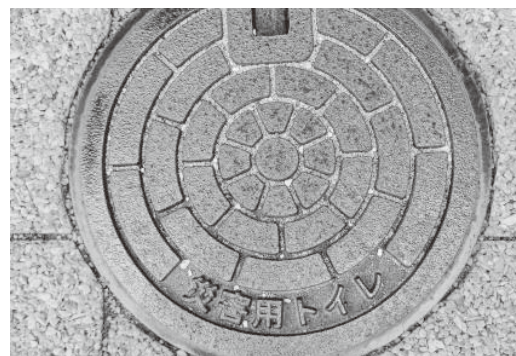
下水道の安全を徹底、マンホールトイレ確保
