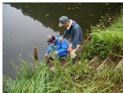
取水施設の点検
