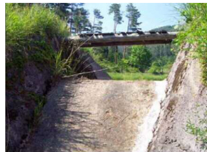
洪水吐の補修
