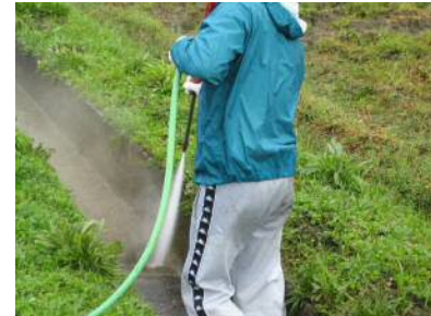
高圧洗浄機による 水路内の清掃
