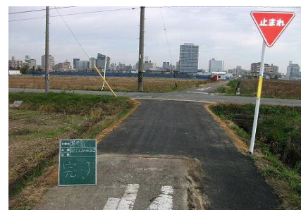
アスファルト舗装の打換え
