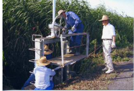
ゲートの点検
