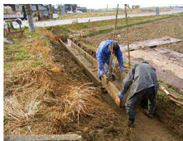
水路の再布設
