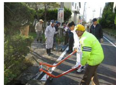
水路蓋の設置 (専用器具使用)
