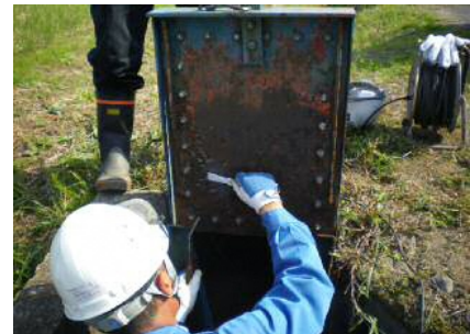
ゲートの補修状況
