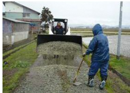
砂利の敷き均し
