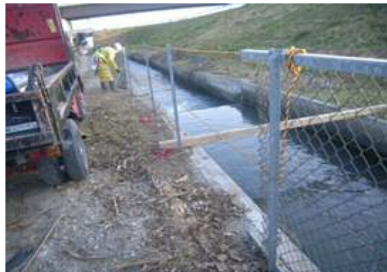
金網フェンスの 設置
