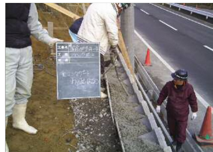
ブロック積みの施工
