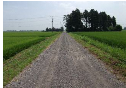
未舗装農道（砂利の路面）
