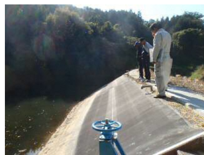
遮水シートの設置
