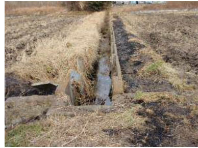
老朽化した水路（全景）
