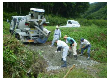
コンクリート舗装状況
