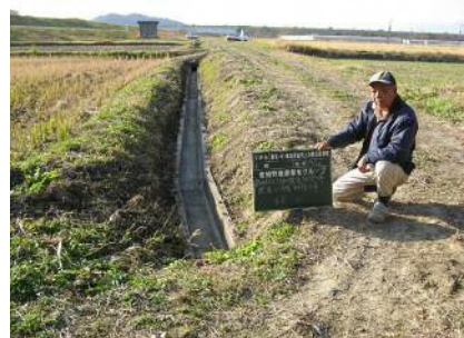
土側溝をコンクリート側溝に更新
