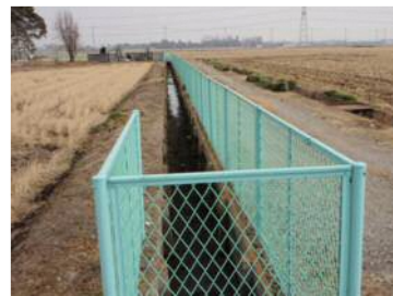
新たに設置された 金網フェンス
