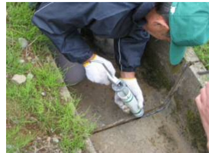
シーリング材充填
