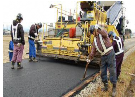
アスファルト舗装状況
