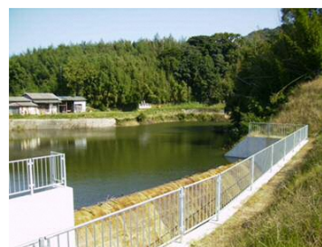
金網フェンスの 設置状況
