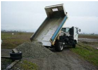
砂利の荷下ろし
