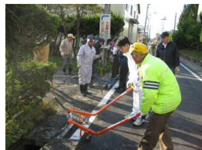
水路蓋の設置 (専用器具使用)
