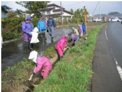
側溝の泥上げ
