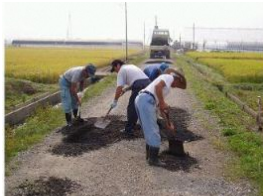
共同作業による砂利の敷き均し
