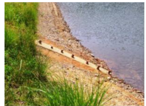
斜樋と取水栓
