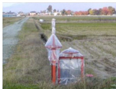
ゲートの被覆状況
