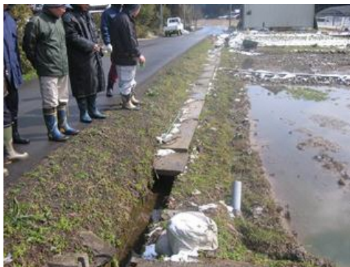
開水路の点検状況
