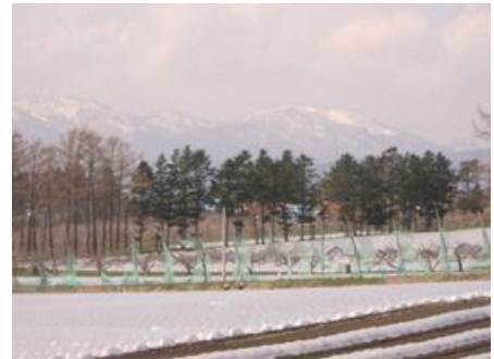
防風ネットの設置状況
