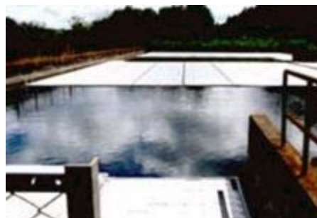
浮揚型の天蓋による部分遮光
