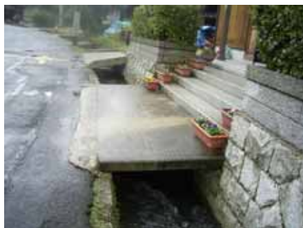
図2-23 住宅前の水路(峰山町長岡付近)
