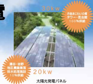
丹後王国タワーの太陽光発電パネルは、 薄膜多結晶とアモルファスのハイブリッドタイプを採用 し、電力消費の多い夏場に発電量が高まるよう工夫が されています。
