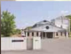
微生物の働きを利用した「オキシデーションディッチ法」を採用して下水汚泥の発生量を抑え、水質汚濁の防止や環境衛生の向上に努めています。
