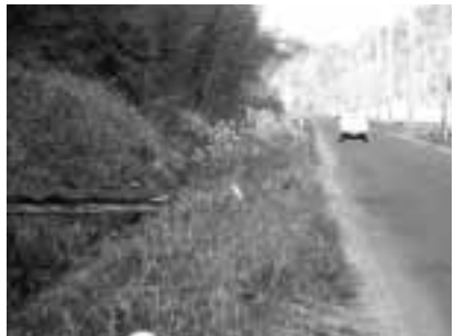
道路のすぐ横の山林からの雑木がはえていた久美浜町内の市道
