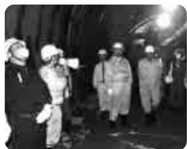
京都府下で2番目の長さとなる「第12トンネル」を視察し、進ちよく状況を確認
