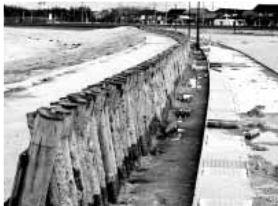
現在整備中の排水路と防砂壁（網野浅茂川海岸）
