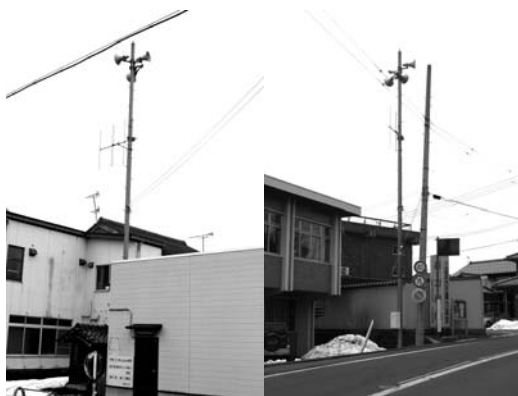
網野町内に設置されている防災行政無線の屋外拡声子局(写真右:網野公民館、左:福田区)
