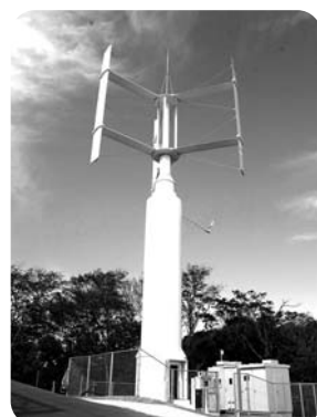
直線翼垂直軸型風力発電機 (スイス村KEEP風力発電施設)
