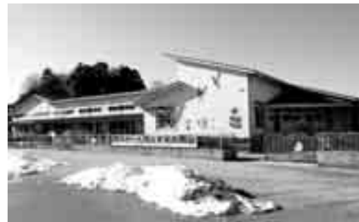
統合の対象となっている口大野保育所。比較的新しく昭和58年に建築
