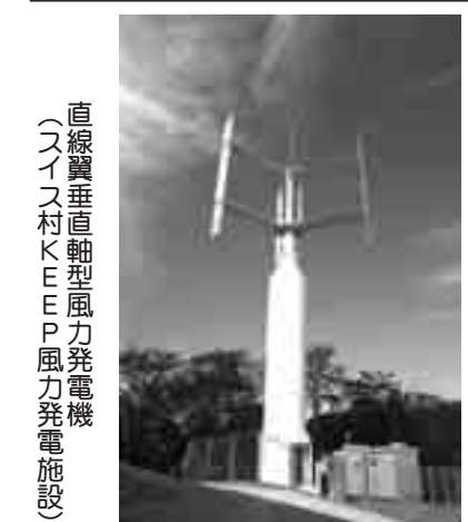
直線垂直直軸型風力発電機 (ツイフ村KEEP風力発電施設)
