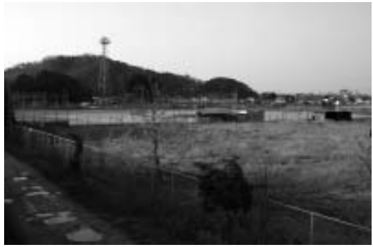
下水処理施設が建設される網野グラウンド(写真奥)。写真手前部分の一部をグラウンド用地として確保の予定
