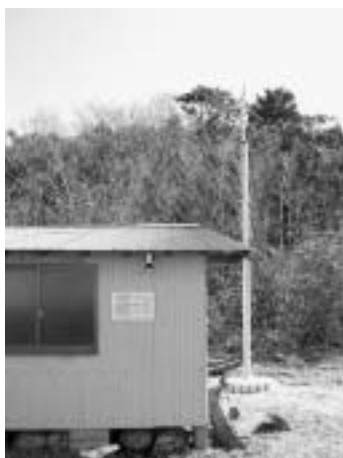
環境学習施設に建てられた 小型風力発電機
