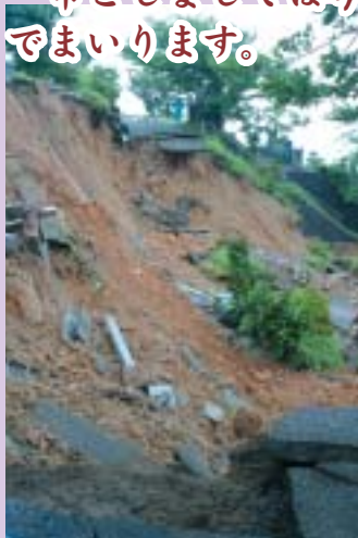
丹後町間人 墓地公園崩落現場
