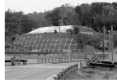
墳丘法面の保全工事中の赤坂今井墳丘墓
