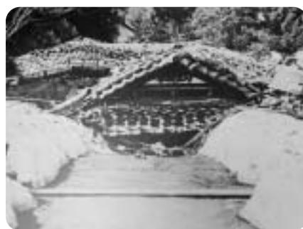
丹後大震災で倒壊した「峰山公会堂」
