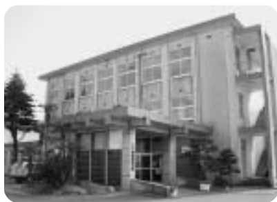
老朽化が著しい 網野中学校管理棟
