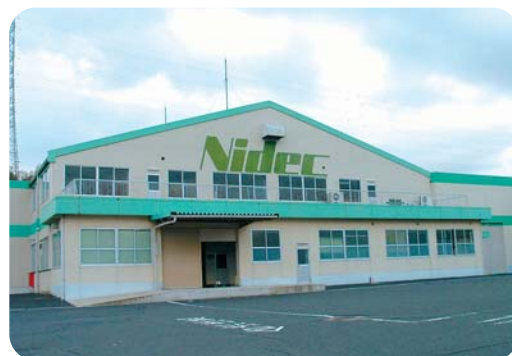
ものづくり産業の振興拠点となる 「北部産業活性化拠点・京丹後」（日本電産旧峰山工場）
