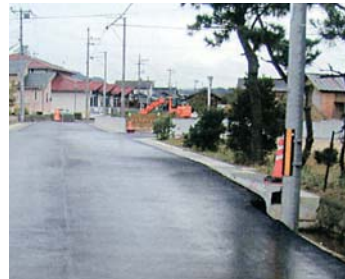
浸水対策の整備が進む 市道浅茂川保育所線
