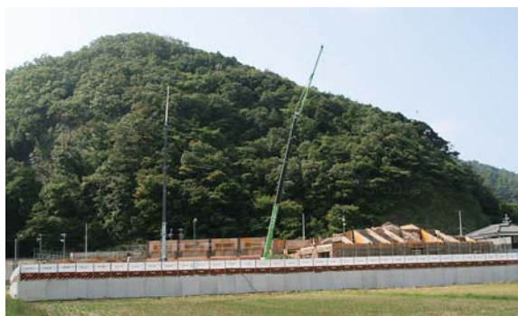
平成21年4月の開所に向けて工事が進む 丹後保育所・幼稚園（丹後町間人）
