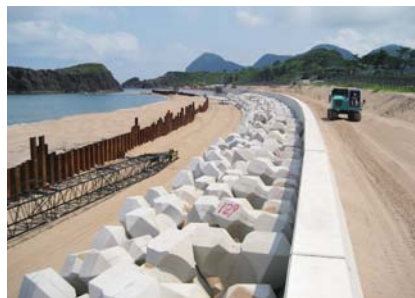
護岸の前面に波を打ち消すブロックを設置
