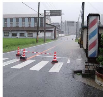
7月28日の集中豪雨で国道482号が冠水 している様子
