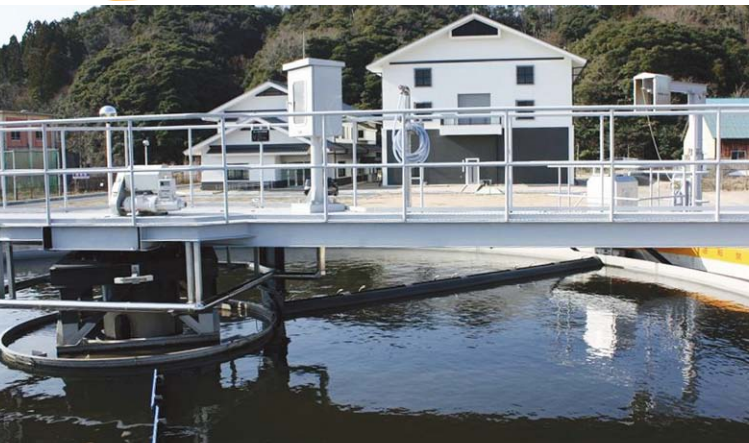
現在の使用料金収入では施設の管理費用すら捻出できないのが現状（写真：網野浄化センター）
