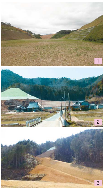
普段見ることができない工事現場の様子を写真で紹介
