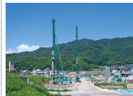
野田川橋梁(仮称)橋梁工事(宮津市須津地内、平成23年7月撮影)
