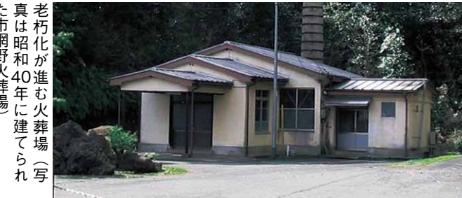
老朽化が進む火葬場（写真は昭和40年に建てられた市網野火葬場）
