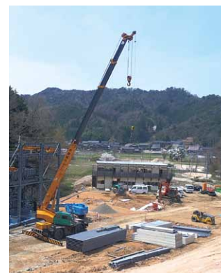
▲第14トンネル (仮称) 付近の工事現場の様子 (大宮町三重)
