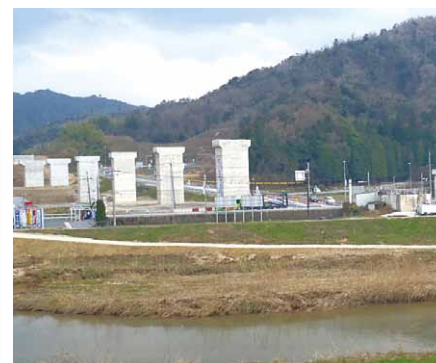
▲国道176号や野田川などをまたぐ橋りょう工事では、すでに6本の橋脚が完成 (宮津市須津)
