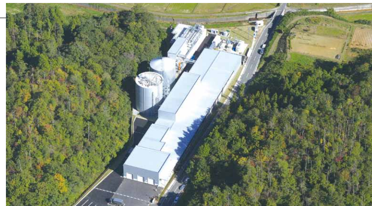
▲京丹後市エコエネルギーセンター
