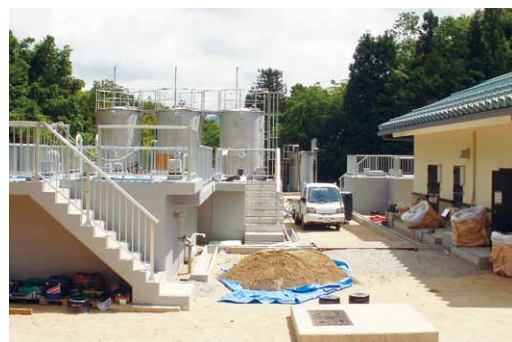
▲整備中の大宮町善王寺の浄水場
