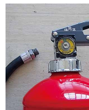
▲ホースが脱落している
